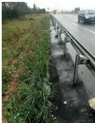
sur l'infiltration, ont été étudiés : un dépollueur compact (Stoppol), des filtres à sable horizontaux non infiltrants, un parking perméable végétalisé (Evovégétal) et un ensemble d'accotements filtrants et de noues filtrantes.
