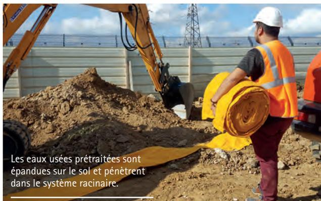
Les eaux usées prétraitées sont épanchées sur le sol et pénètrent dans le système racinaire.
