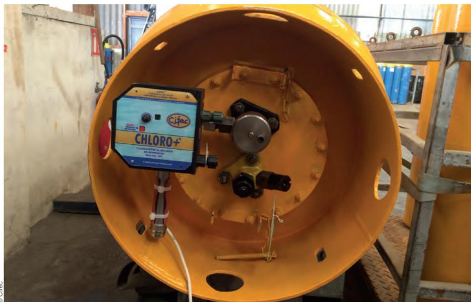
Le chlorodétendeur Chloro+ s'emploie pour le dosage de chlore gazeux.
