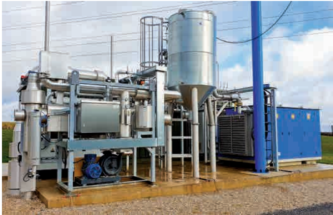
C'est dans cette partie de l'installation que le biogaz est préparé et traité en vue de son injection dans le réseau. Il contient au moins 94 % de méthane.
