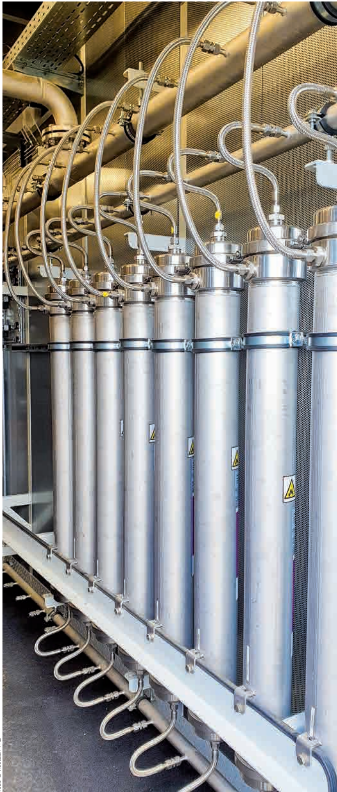
Afin de purifier le gaz, il passe dans ces cartouches qui vont permettre d'isoler le CO 2 et le CH 4 .
