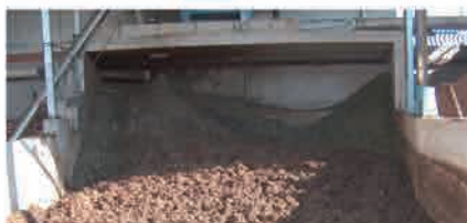
Effluents Industriels (liqueur noire, ...)
