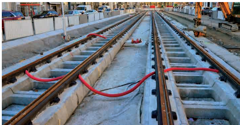
Procédé de pose de voies par blocs d'augets doubles préfabriqués. Les gaines au premier plan protègent les câbles d'équipotentialité
