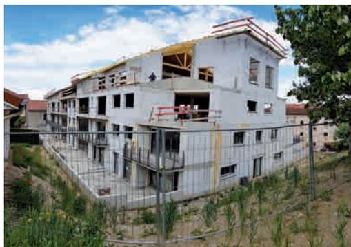
au niveau des coupes, avec la scie, on réalise un travail parfait. Cela se prête très bien à la construction de maisons sur-mesure qui comportent parfois des angles, des Y, des formes qui sortent de l'ordinaire » explique-t-il. Le format du bloc permet un gain de temps de l'ordre de 30%. La pose est facilitée par la légèreté des blocs, moins de 20 kg, et leur maniabilité. Le projet sera livré en juin 2020.
