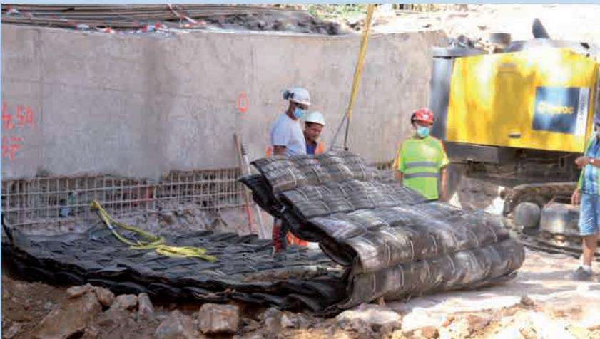
L'ensemble du pas de tir est ensuite recouvert par des tapis de protection de 1,3 tonne.
