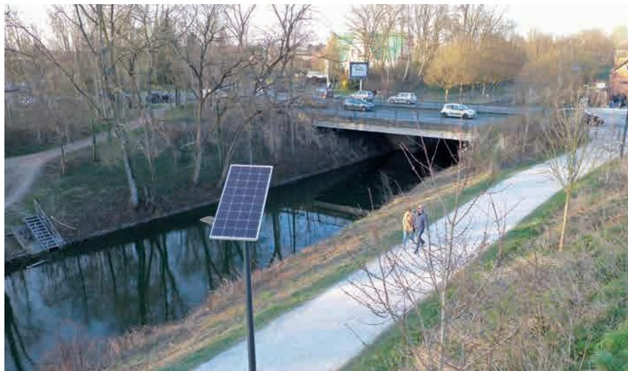
avant l'aube. Cela permet d'éclairer la zone uniquement lors de la présence des usagers. Pour préserver la biodiversité propre à la ville, la température de couleur de l'éclairage est plus orangée (2200 K), et celui-ci ne donne pas sur l'eau afin de ne pas perturber les espèces aquatiques grâce à des optiques spécifiques.
