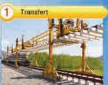
La méthode repose sur un système modulaire pour une manutention sans déformation des panneaux de voie avec :
