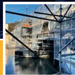
Les échafaudages suspendus pour l'entretien des ponts
