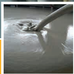
Chapes fluides : couler pour mieux construire
